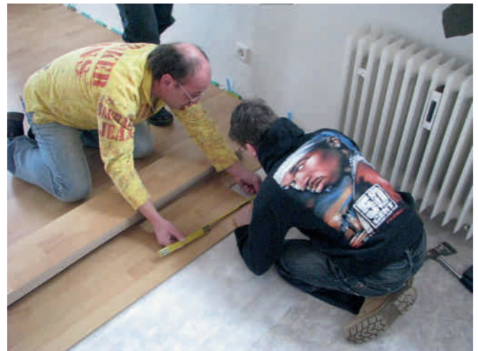
„Boden verlegen in der Trainingswohnung“, Eltern und Schüler helfen mit
